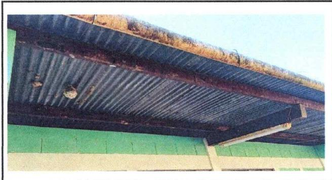
Foto1: Se observa deterioro de la estructura metálica (costaneras y tijeras)
