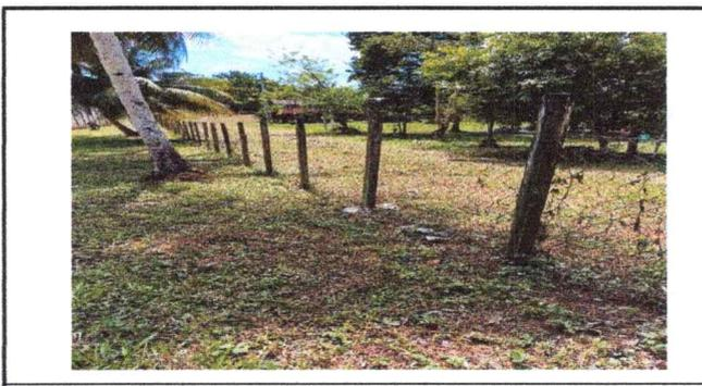
Foto 6: Se observa el deterioro de la malla y los postes
