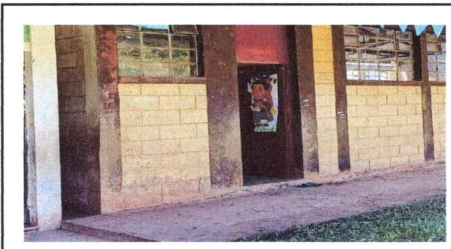
Foto 4: Se Observa el deterioro de la pintura del módulo 2.
