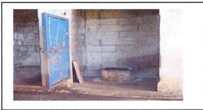
Foto 5: Se observa el deterioro de la puerta y pintura del interior y exterior de la pared y se observa también la humedad de la letrina del módulo 3.
