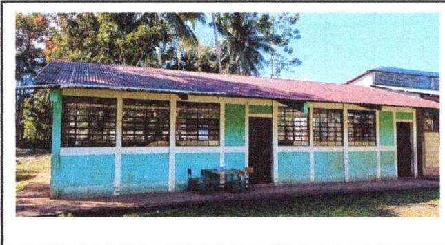
Foto 2: Se Observa deterioro del techo de laminas
